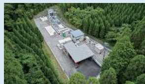
地熱発電利用水素製造プラント ((株)大林組)
