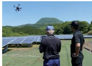
柳井電機工業(株)の太陽光発電検査ドローンによるパネル検査
