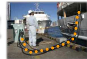
電力供給設備
